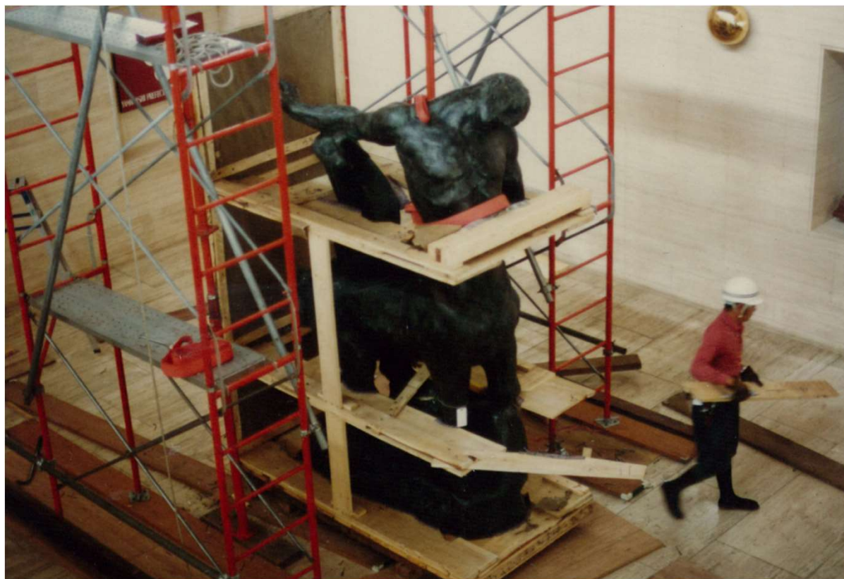
エントランス・ロビーでの設置作業
