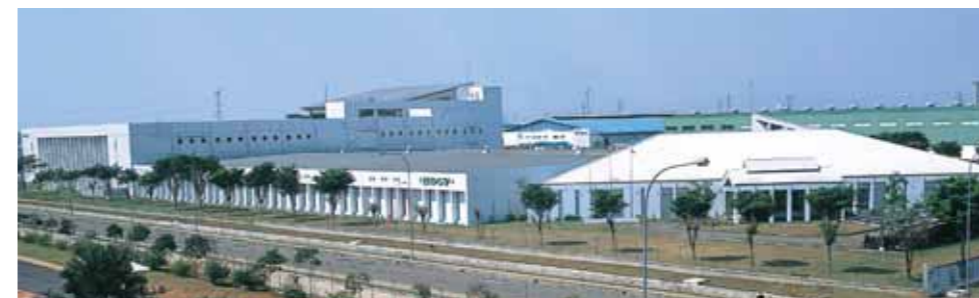
P.T. ホギインドネシア第1工場 P.T. HOGY Indonesia No.1 Plant
