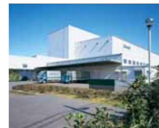
江戸崎配送センター Edosaki Distribution Center
