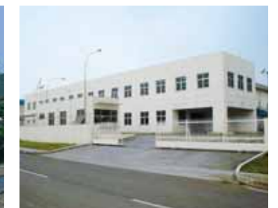
P.T. ホギインドネシア第2工場 P.T. HOGY Indonesia No. 2 Plant
