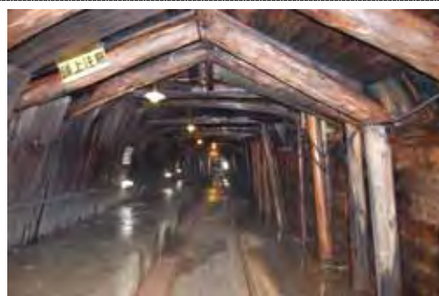
【通洞坑】 (栃木県日光市)
