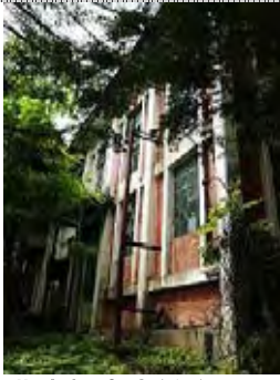
【北炭幌内炭鉱変電所】 (北海道三笠市)
