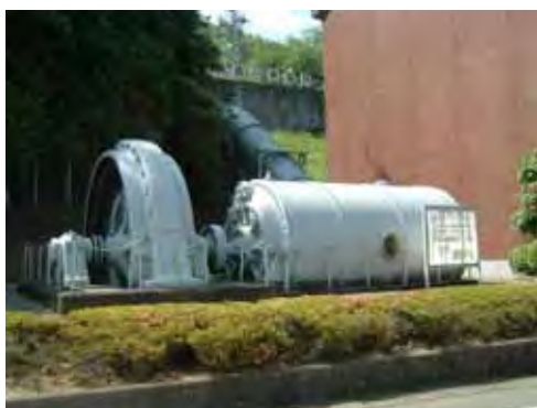
【長良川水力発電所（発電機）】 （岐阜県美濃市）
