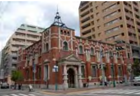
【旧第一銀行神戸支店(現:みなと元町駅)】 (神戸市中央区)
