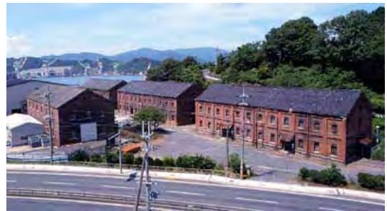
【近畿財務局煉瓦倉庫(右3棟) 海上自衛隊舞鶴造修補給所 No.17 倉庫(左1棟)】 (京都府舞鶴市)
