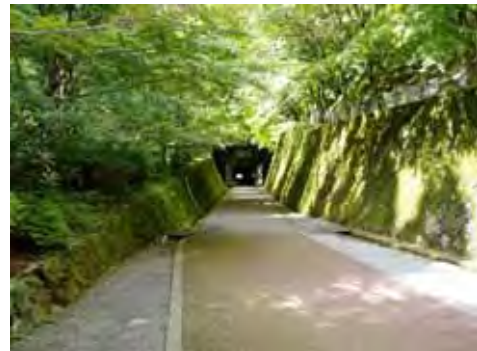
【銅生金山 坑道(入口)】 (大分県日田市)
