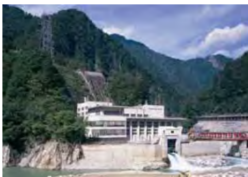
【黒部川第二発電所】 （富山県黒部市）
