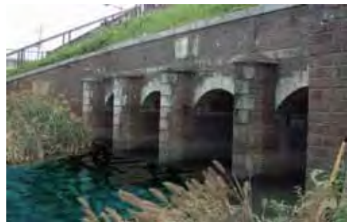
【柳原水閘】 (千葉県松戸市)
