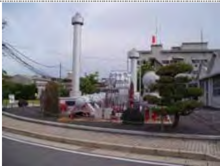
【カザレー式アンモニア製造装置】 (宮崎県延岡市)
