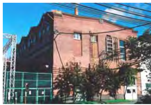
【王子製紙（株）苫小牧工場内変電所】 （北海道苫小牧市）
