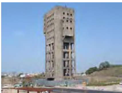
【志免鉱業所竪坑櫓】 （福岡県粕屋郡志免町）
