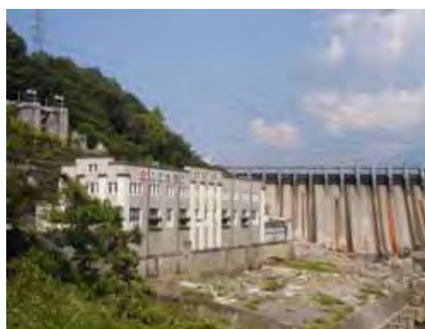
【大井ダム、大井発電所】 （岐阜県恵那市、中津川市）
