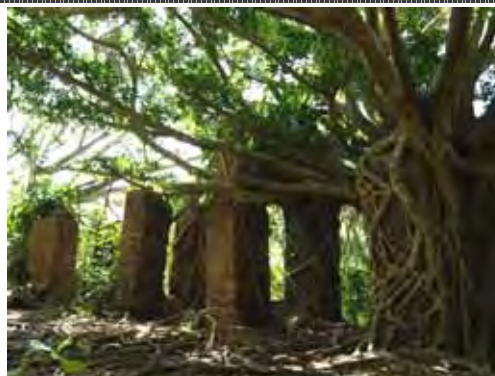
【宇多良炭鉱跡 橋梁跡】 (沖縄県八重山郡竹富町)
