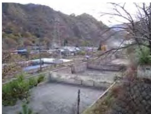
【間藤浄水場】 (栃木県日光市)
