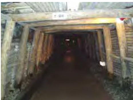
【銅生金山 坑道(内部)】 (大分県日田市)
