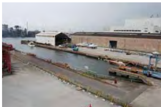
【名村造船所跡地】 （大阪府大阪市住之江区）
