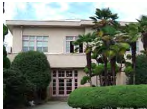
【東洋精機㈱ 本館事務所】 （兵庫県尼崎市）
