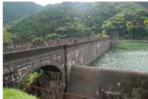
【河内貯水池】 (福岡県北九州市)
