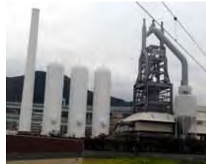
【東田第一高炉跡】 (福岡県北九州市)
