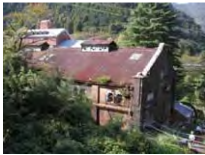
【別子銅山 旧端出場水力発電所】 (愛媛県新居浜市)
