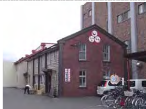
【醤油製造工場(福山醸造㈱)】 (北海道札幌市東区)
