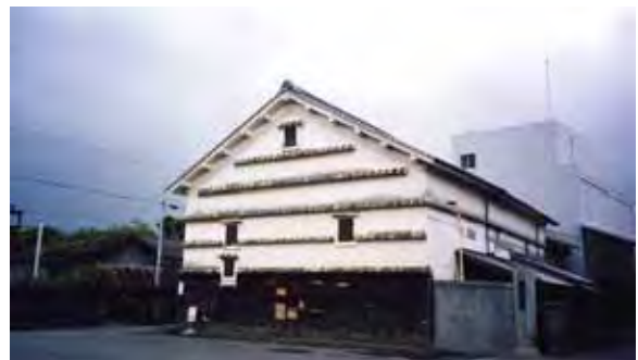
【藤村製糸 倉庫】 (高知県安芸郡奈半利町)
