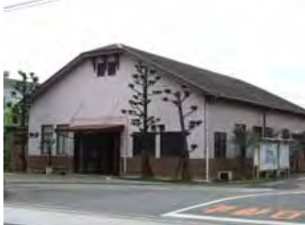
【日本スピンドル製造㈱ 事務所】 （兵庫県尼崎市）
