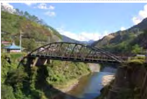
【古河橋】 (栃木県日光市)
