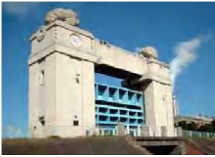
【川崎河港水門】 (川崎市川崎区)
