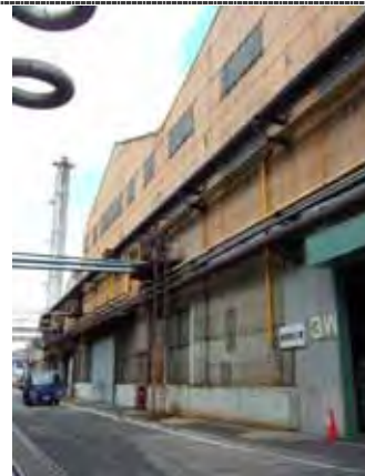
【住友金属工業㈱鋼管カンパニ - 特殊管事業所 鍛造管工場】 （兵庫県尼崎市）
