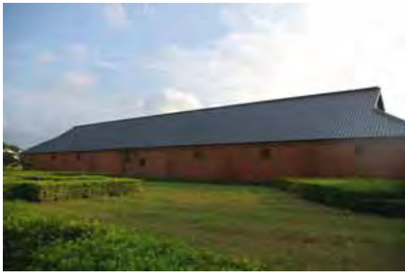
【煉瓦蔵(キッコーマン跡)】 (千葉県野田市)
