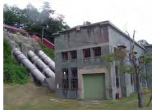
【王子製紙（株）尻別第1発電所】 （北海道虻田郡二セコ町）
