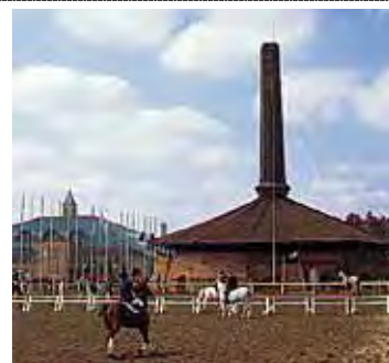
【旧下野煉化製造会社瓦窯】 (栃木県下都賀郡野木町) 改修中につき、非公開
