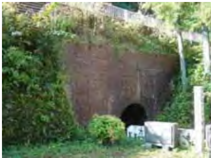
【釜石鉄道 小川レンガ橋梁】 (岩手県釜石市)
