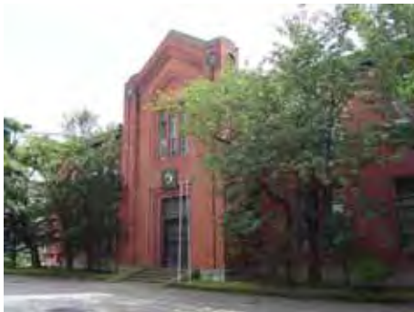
【王子製紙（株）苫小牧工場旧事務所】 （北海道苫小牧市）
