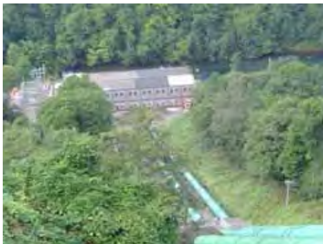
【王子製紙（株）千歳川第1水力発電所】 （北海道千歳市）
