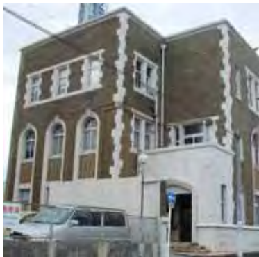
【旧尾西織物同業組合事務所】 （愛知県一宮市）
